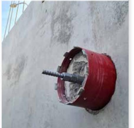
Der Bohrkern wird sicher an der Vorschubstange gehalten und kann anschließend einfach entfernt werden.
