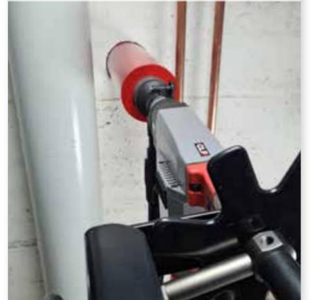
Bohrungen an engen, schwer zugänglichen Stellen, z.B. bei bereits vorhandenen Rohrinstallationen und baulichen Gegebenheiten wie Deckenvorsprung oder Fenstersturz.
